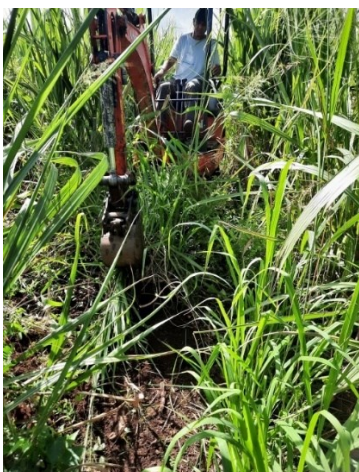
Dessouchage mécanique avec une mini pelle
