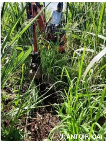
Dessouchage mécanique avec une mini pelle
